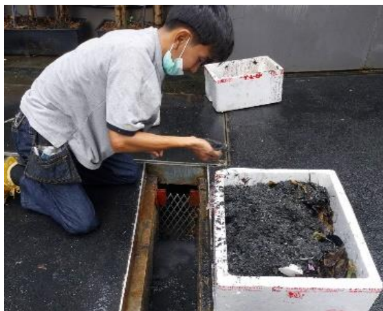
ภาพที่ 2.2-15 เจ้าหน้าที่ลอกท่อระบายน้ำ
