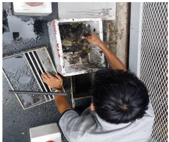
ภาพที่ 2.2-15 เจ้าหน้าที่ลอกท่อระบายน้ำ
